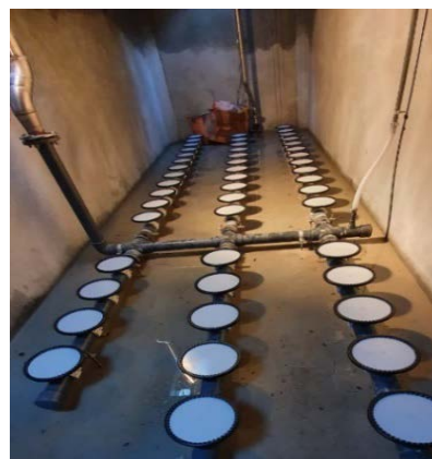
Fig. 8 - Tappeto diffusori per insufflazione aria
